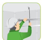
4. ล็อกโครง SCL แนวตั้งเข้ากับชุดหัวโครงป.ปลา ปรับระดับโครงตามต้องการ โดยการปรับสปริงปรับระดับ
