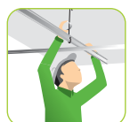
6. ตรวจสอบระดับโครง SCL แนวนอน อย่างละเอียดอีกครั้งก่อนติดตั้งแผ่นยิปซัม SCL มอก.
